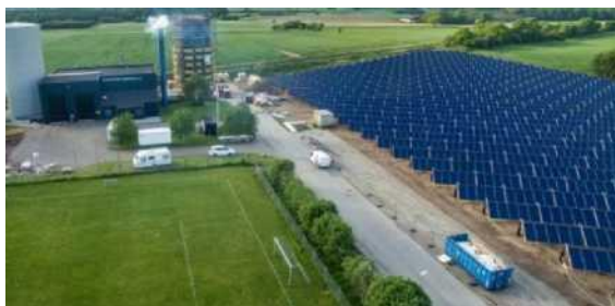
Figura 6.22 - Sistemul solar și sistemul de stocare aferent termoficării din Trustrup-Lyngby (Danemarca) (cf. cu http://arcon-sunmark.com/ )
